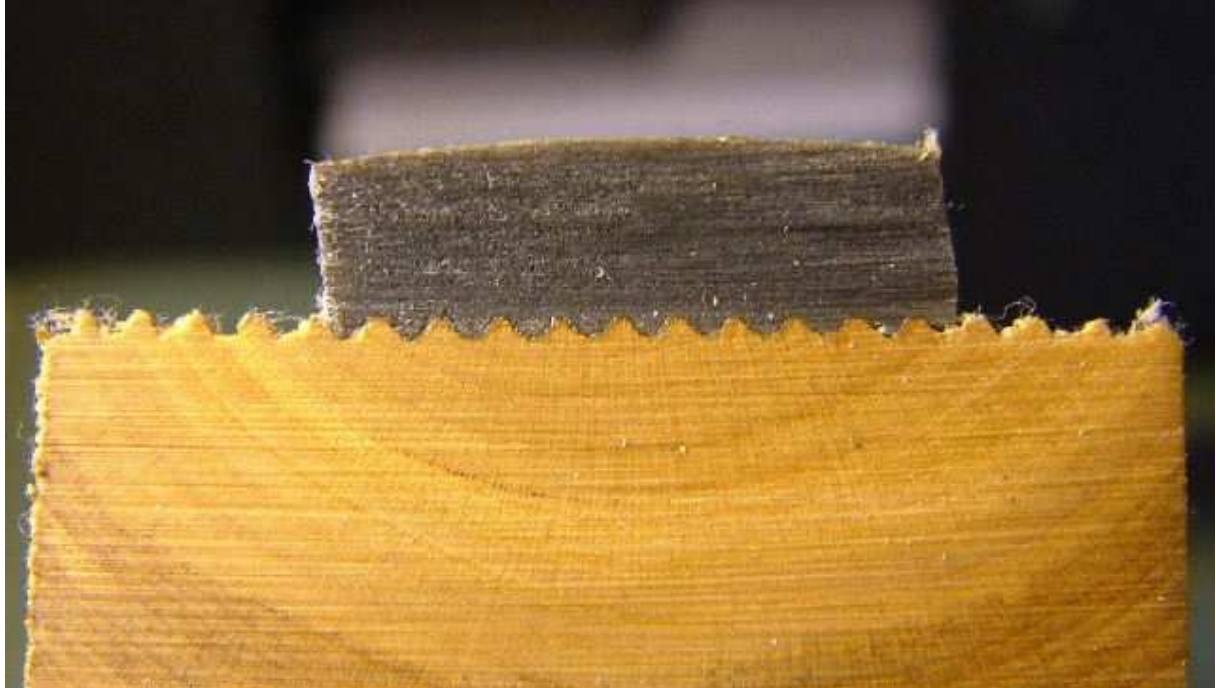
Abb. 3: Verzahnung zwischen Holz- und Hornleisten
